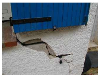
Figure 3-12 : Sol argileux à gauche et fissuration due au retrait-gonflement d'argiles à droite (BRGM)
