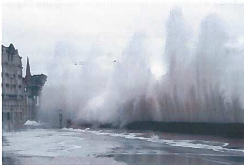
Figure 2-3: Franchissement de la Digue du Sillon – 10 mars 2008 (in Cariolet 2011)
