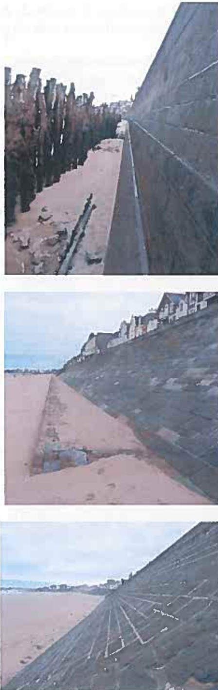
Figure 2-25 : Digue du Sillon (en haut), digue Palmié (au centre) et digue de Paramé (en bas) (Photos : CETE Ouest, novembre 2010)
