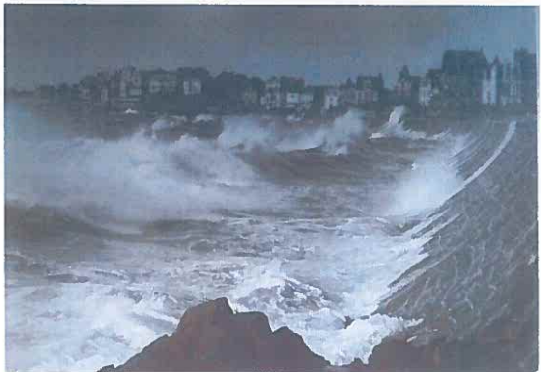
Figure 3-20 : Déferlement des vagues sur la section courbe de la digue de Paramé
