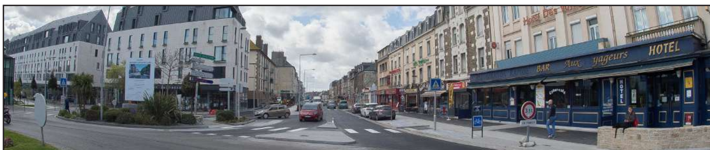
Aménagement de pistes cyclables, avenue des Talards
