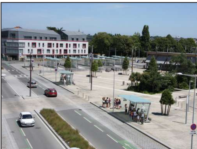
Le pôle d'échanges multimodal à proximité de la gare
