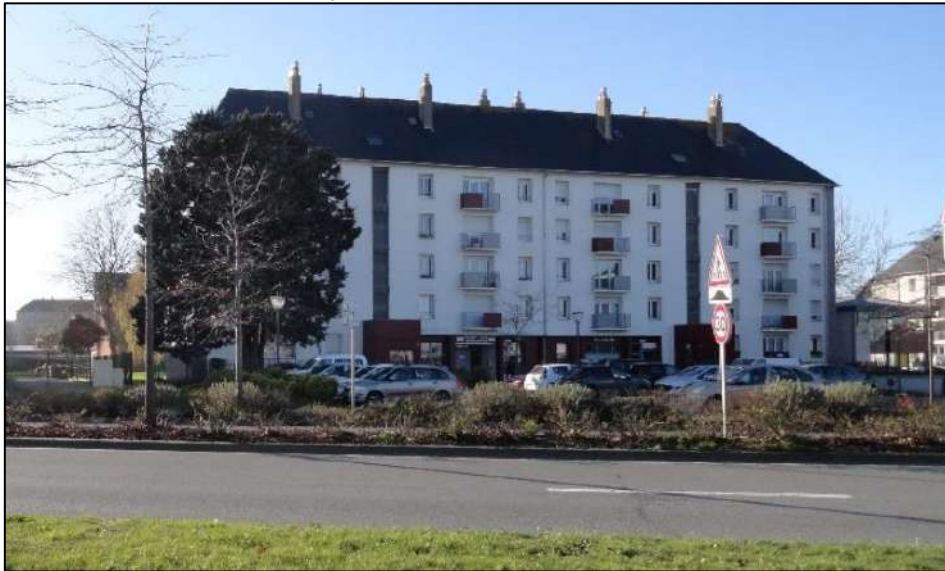
Bâtiments historiques de la Découverte en R+4+C
