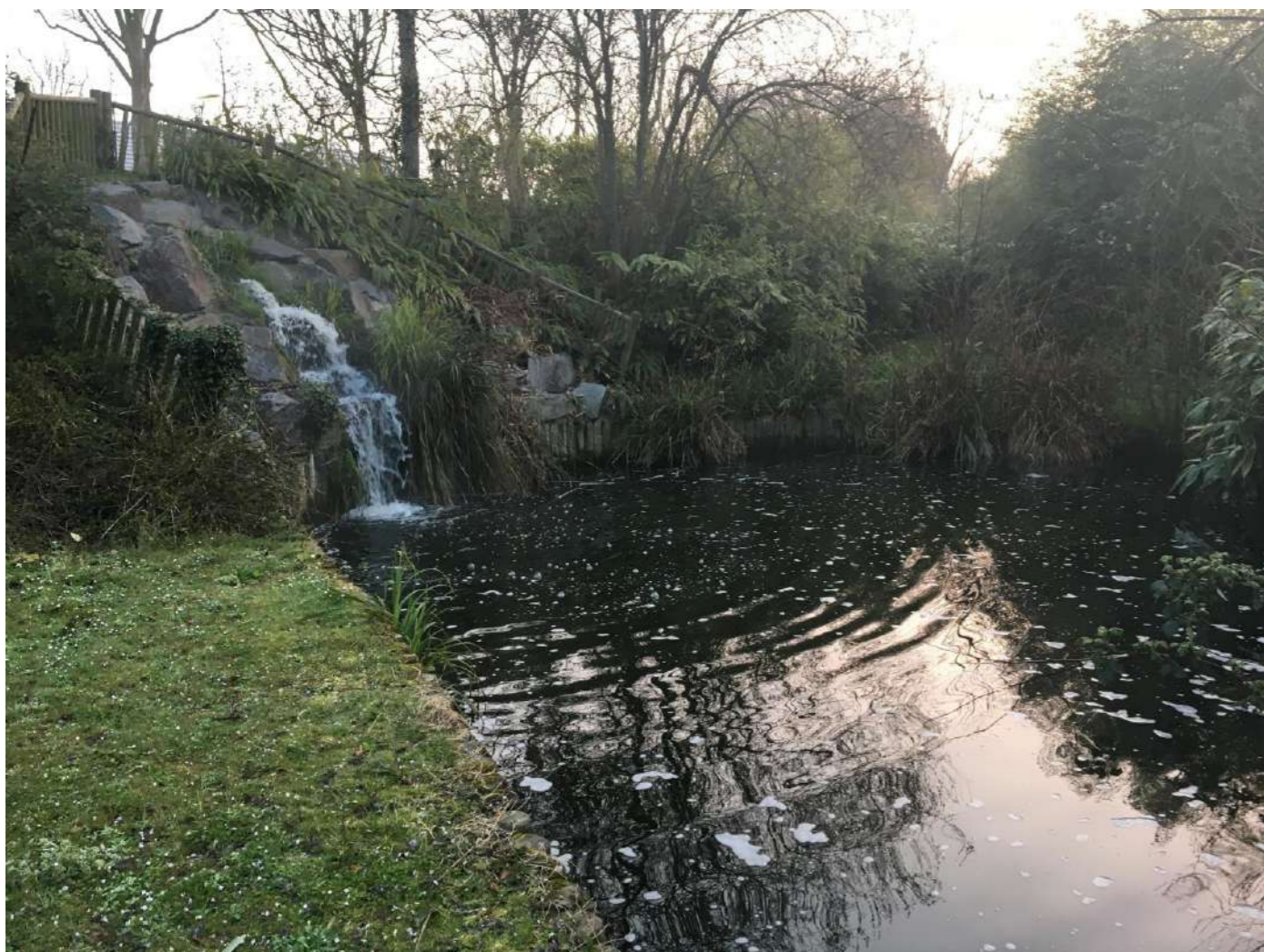
FIGURE 16 : VUE DE L'ESPACE AQUATIQUE PERMETTANT UN TAMPONNEMENT DES EAUX PLUVIALES ET PRESENTANT DES MILIEUX INTERESSANTS EN FRANGE SUD DE LA ZONE D'ETUDE (SOURCE : IAO SENN)
