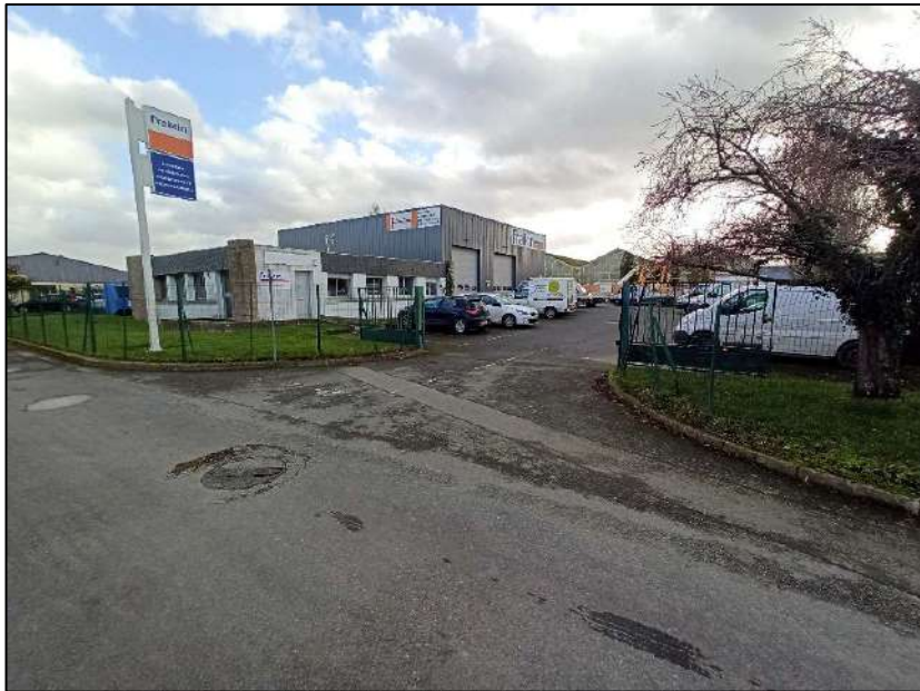
Constructions de la rive sud de la rue Saint Fiacre
