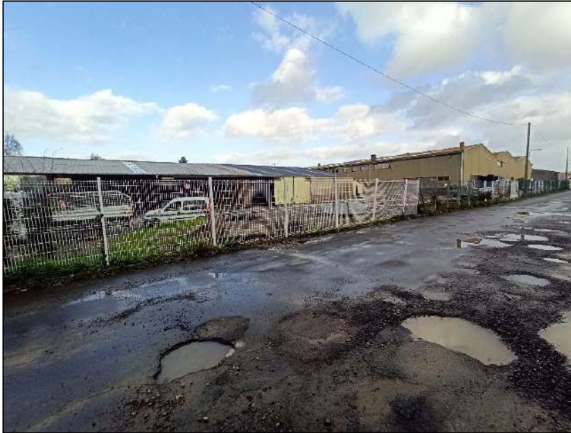
Constructions de la rive nord de la rue Saint Fiacre
