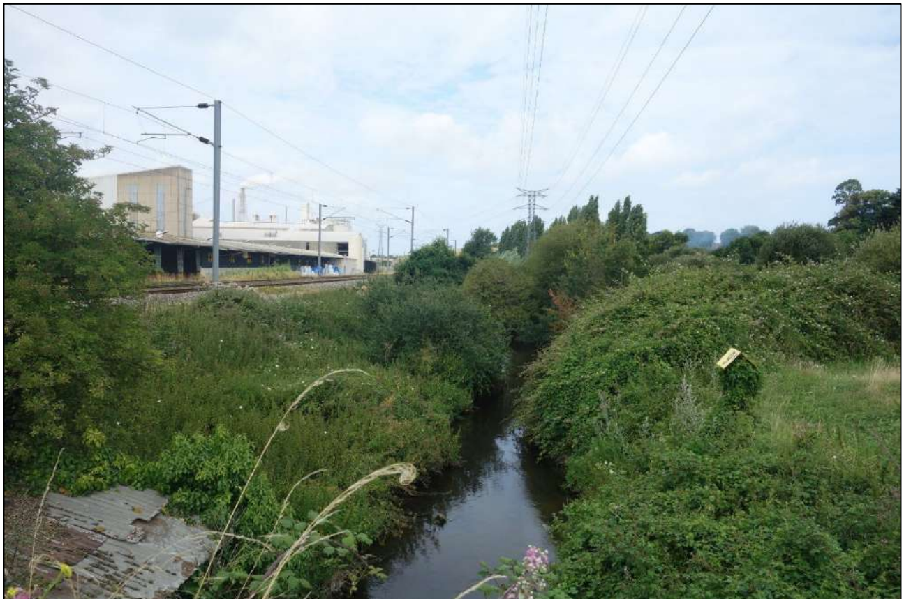
Le Routhouan dans sa partie aérienne au droit de l'entreprise de La Timac
