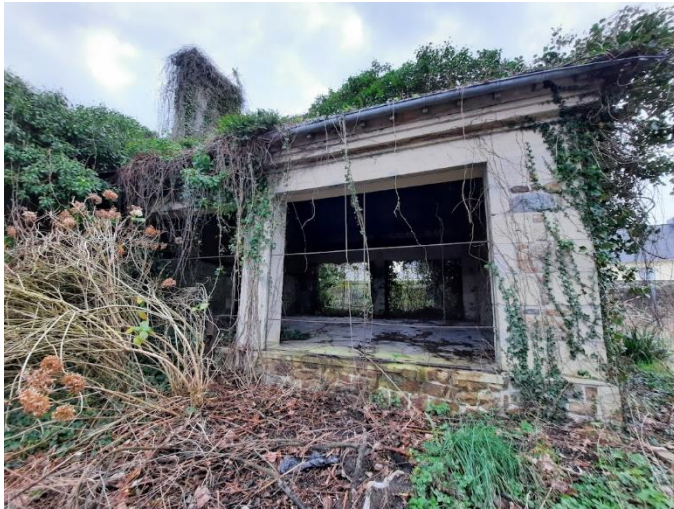
Une des 2 zones refuge des travaux de la Lorette
