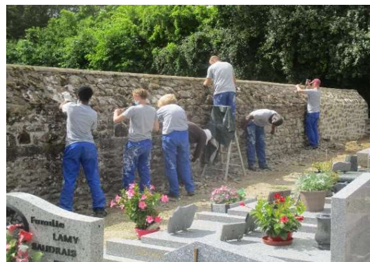
PIQUETAGE DES MURS
