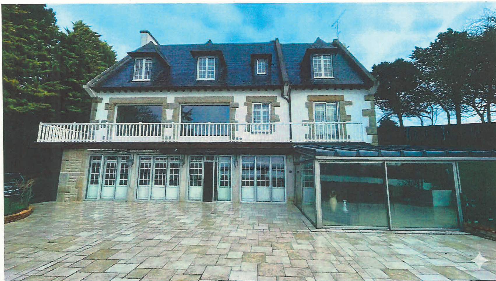
FAÇADE SUD EXISTANTE
