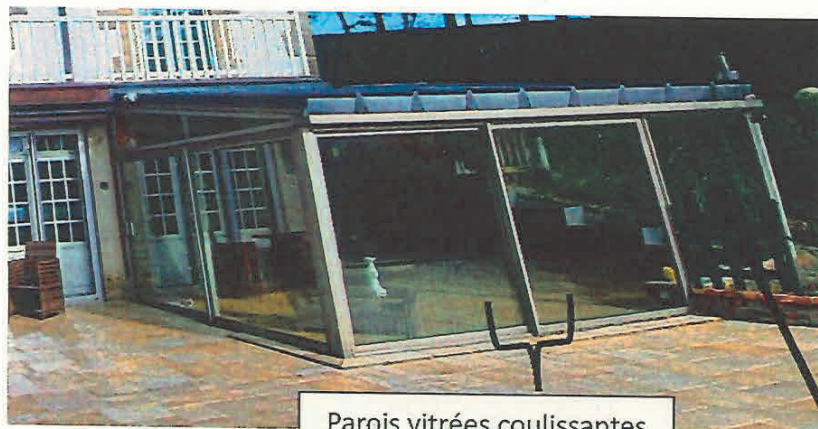
Façade Sud véranda existante
