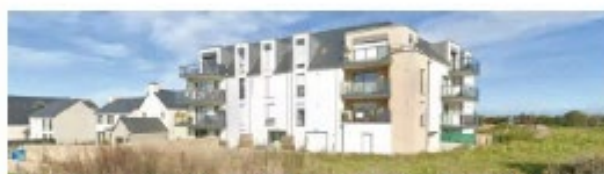
Logements collectifs - Bonne rencontre Sud - 4 Niveaux
