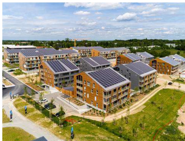
Eco-quartier La Fleuriaye à Carquefou, avec 8 000m 2 de panneaux en autoconsommation collective (logements + bâtiments tertiaires). On remarque la répartition en 1/3 – 2/3 des pans de toiture pour maximiser la surface exposée sud.
