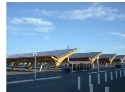
Ombrière photovoltaïque avec structure bois
