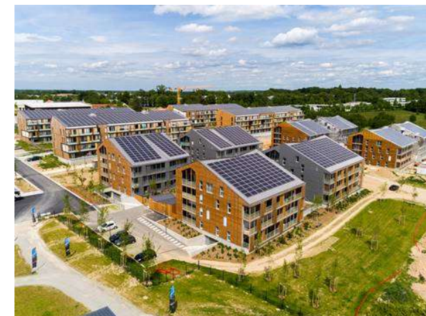
Eco-quartier La Fleuriaye à Carquefou, avec 8 000m 2 de panneaux en autoconsommation collective (logements + bâtiments tertiaires). On remarque la répartition en 1/3 – 2/3 des pans de toiture pour maximiser la surface exposée sud.
