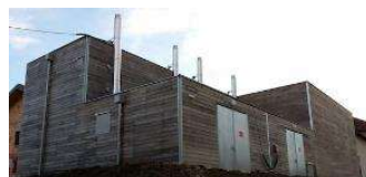
Chaufferie bois préfabriquée de 800 kW, Montlebon (25)
