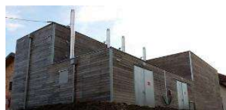
Chaufferie bois préfabriquée de 800 kW, Montlebon (25)
