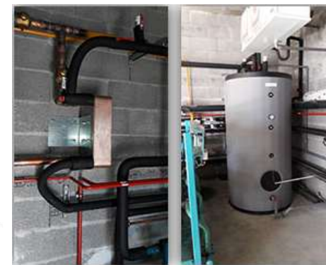
Exemple d'un échangeur (récupérateur) raccordé sur un ballon tampon
