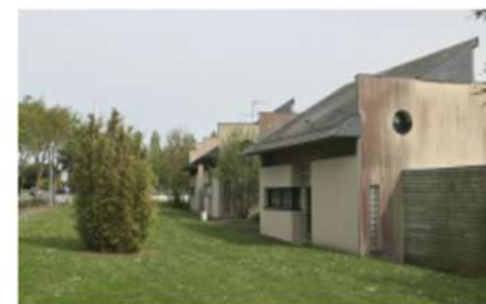
Maison de fonction du personnel de l'IUT
