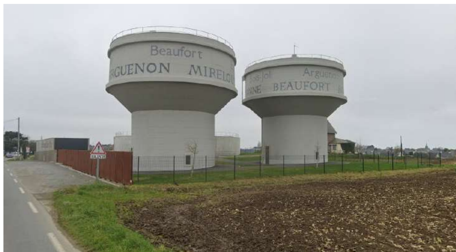
Figure 134 : Prise de vue du Château d'eau de Saint-Malo - février 2023 - Google
