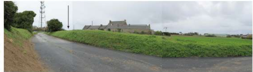
1 Le talus Nord
