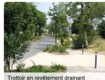
Trottoir en revêtement drainant
